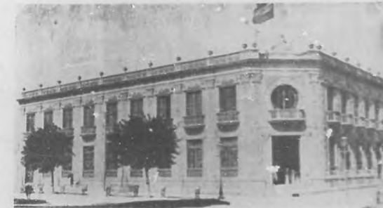
El edificio del Casino Español de Sagua la Grande.
